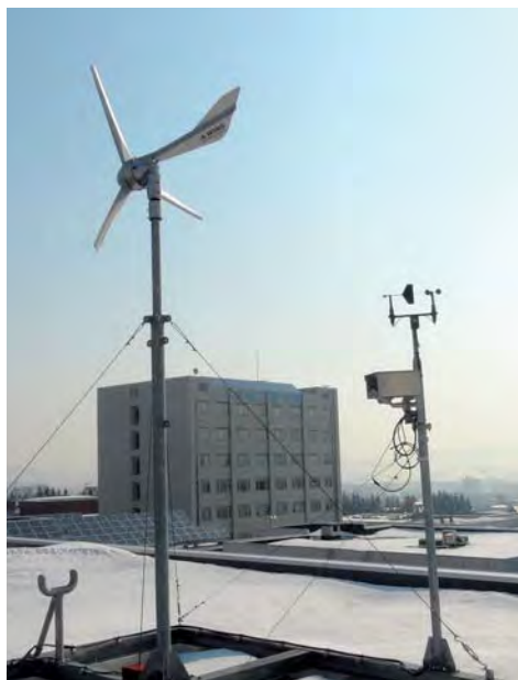
写真左上) 街路灯用プロペラ風車(最大出力400ワット、道東自動車道・由仁PA) 写真左下) 北見工大屋上風車(最大出力500ワット) 写真下) 宗谷岬ウインドファーム(ユースエナジー)1,000キロワット×57台～総出力57,000キロワット
