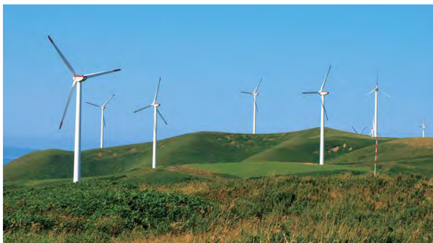
写真左上) 街路灯用プロペラ風車(最大出力400ワット、道東自動車道・由仁PA) 写真左下) 北見工大屋上風車(最大出力500ワット) 写真下) 宗谷岬ウインドファーム(ユースエナジー)1,000キロワット×57台～総出力57,000キロワット
