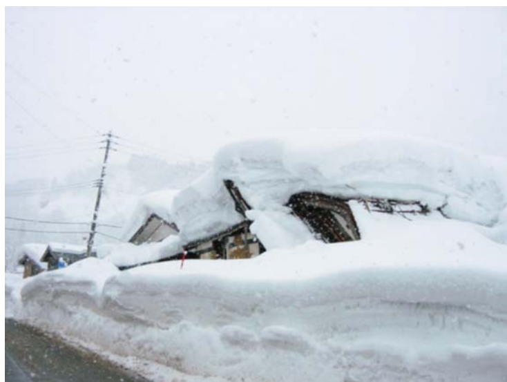
新潟県中越地震における地震と雪害の複合被害の例
