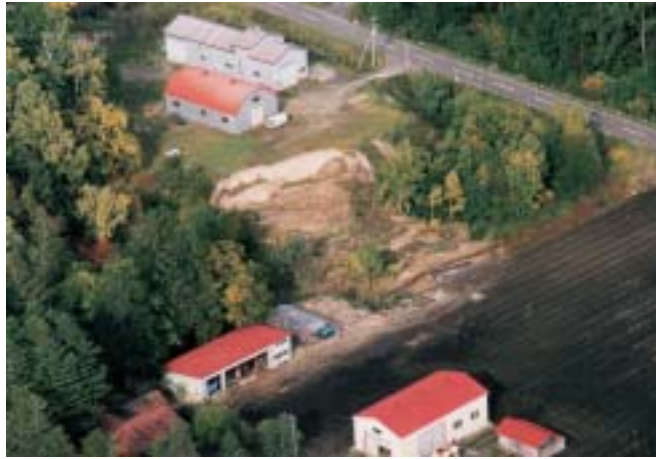
写真1 北見市広郷南5線西14号での液状化による盛土地盤の地すべり
