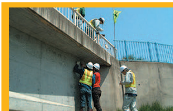
橋梁の維持管理に向けた調査
