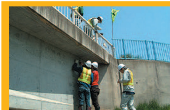
橋梁の維持管理に向けた調査
