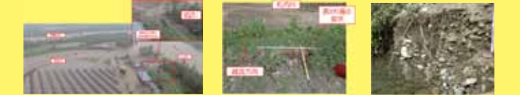
図1 破堤箇所の状況(帯広開発建設部提供資料に加工) 図2 表のり面の植生に倒伏と変状 図3 堤体下部の地盤状況
