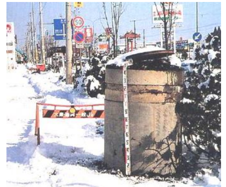
う 浮いてきたマンホール
