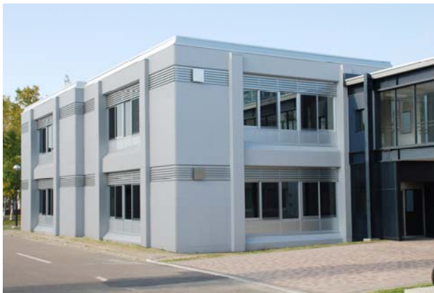
耐震改修後の外観
