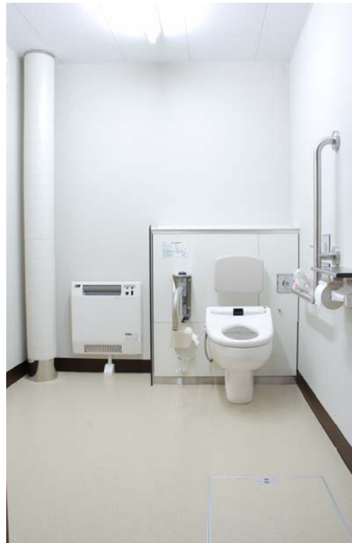
新設された身障者トイレ
