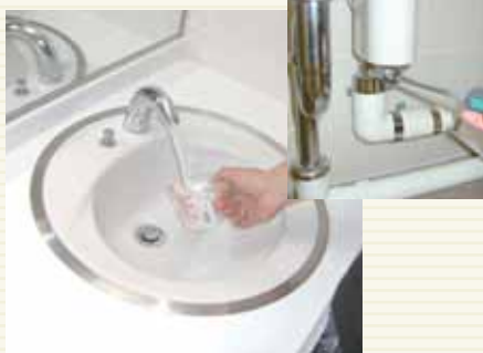
自動水栓の水量調査・調整
