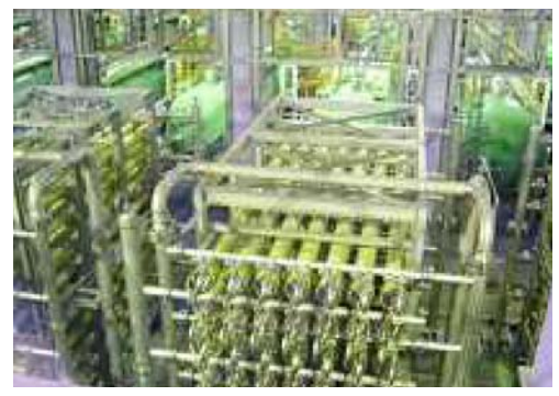
海水淡水化施設 ～日本の最先端技術を使い海水から水道水が作られています。
