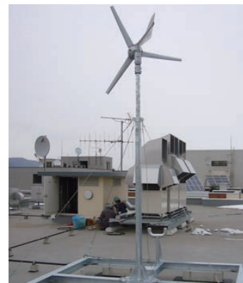
北見工大屋上風車(最大300ワットの出力)
