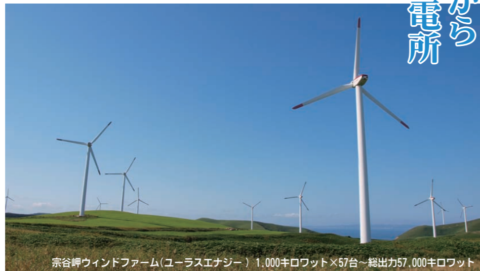
宗谷岬ウィンドファーム(ユラスエナジー) 1,000キロワット×57台~総出力57,000キロワット
