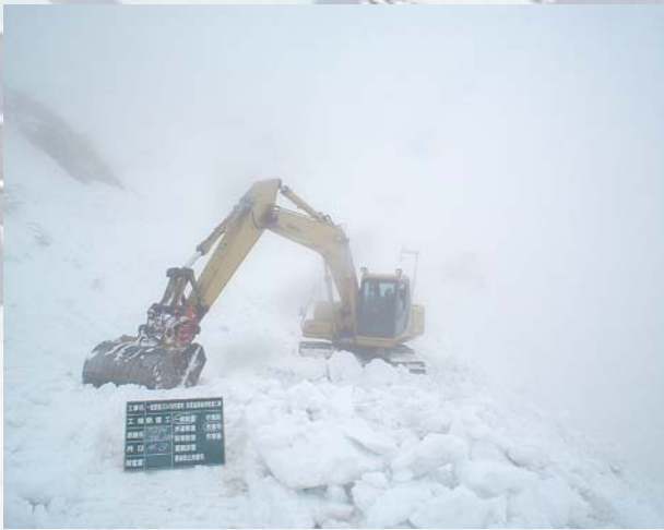
視界不良の中での除雪作業
