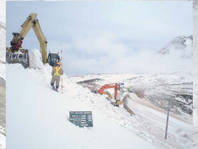
知床峠での除雪作業
