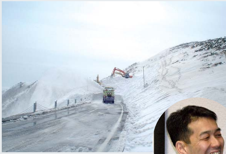
除雪が進み路面が見え始めた 知床横断道路
