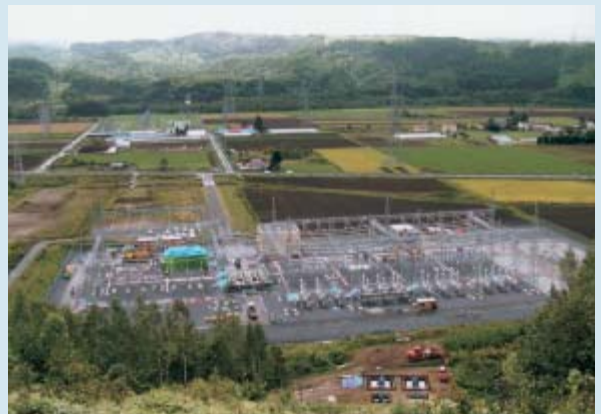
北海道初の屋外母線式275 kV開閉所(建設工事中)
