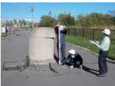
写真1 液状化現象によるマンホールの浮き上がり(2003年十勝沖地震豊頃町)
