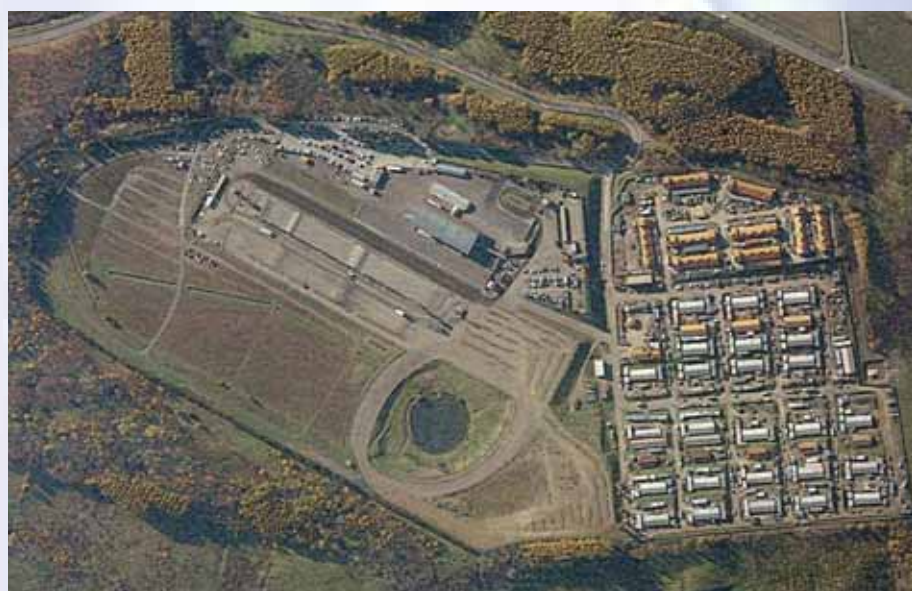
北見工業大学が教育・研究フィールドとして活用を決めた北見市の遊休公施設 31.5ヘクタールのフィールドを大きく1)工農ゾーン、2)森林・河川・環境ゾーン、3)寒冷地ゾーンに分け、土壌のモニタリングに関する調査やハッカ(薄荷)の栽培、森林、河川の生態調査、そして寒冷地における橋の耐力の研究、冬季スポーツや積雪貯蔵に関する研究を実施する予定である。また、自動車技術の走行試験や子供向け科学教室も実施する予定としている。
