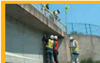
橋梁の維持管理に向けた調査
