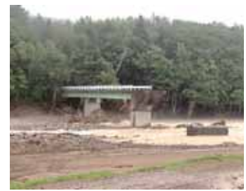
図1 洪水によって流された橋のたもとの盛土(橋だけが残っている…)
