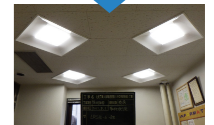
共用部照明72灯をLED化
