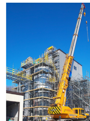
工場建設現場
