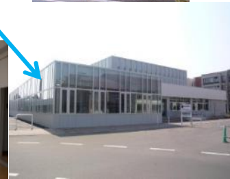
図書館 (平成20年1月改修)
