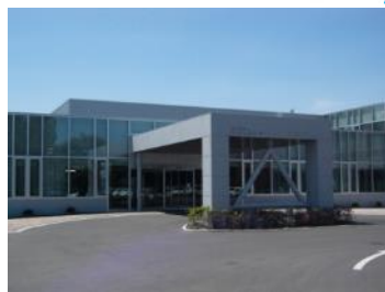
1号館正面玄関 (平成19年2月改修)
