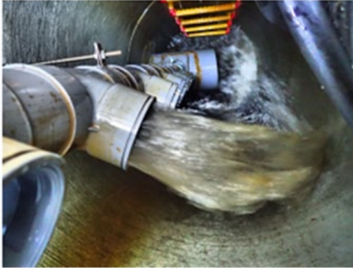
地下水位低下工法の様子
