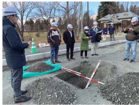
北見市内の道路建設現場の視察
