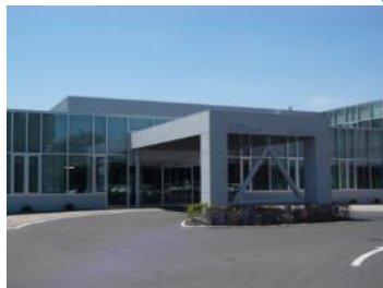
1号館正面玄関 (平成19年2月改修)
