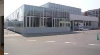
図書館 (平成20年1月改修)
