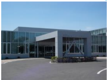
1号館正面玄関 (平成19年2月改修)
