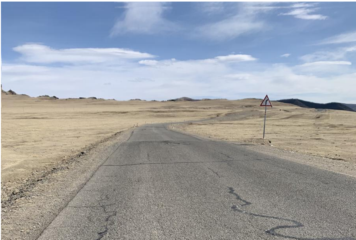
現地の道路状況
